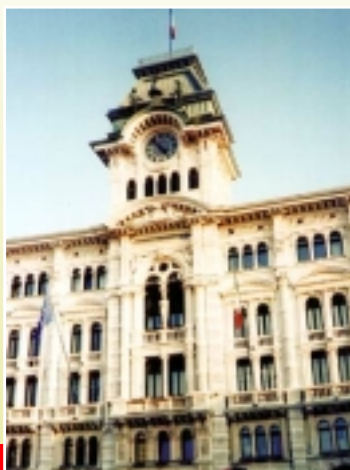
Frete del edificio municipal de Trieste.
